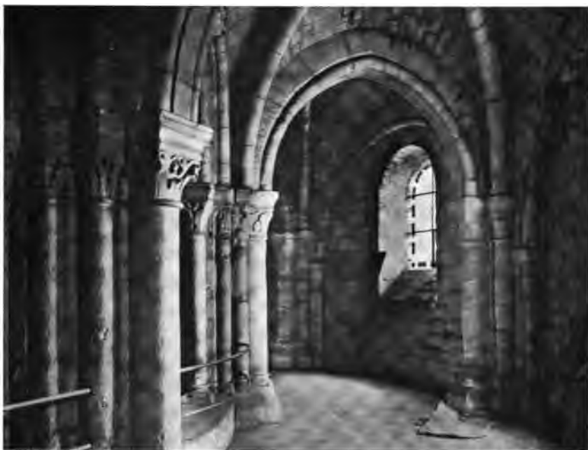
Fig. 147. — Voûte d'arêtes sur les tribunes du chœur à la cathédrale de Senlis. Indécision de la retombée des arcs diagonaux sur les tailloirs des chapiteaux non orientés.
